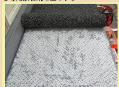
安全のため、手袋・保護メガネを着用し、設置箇所へ接着剤を出し、ヘラ等でムラなく伸ばします。使用目安:400~700g/m<sup>2</sup>
