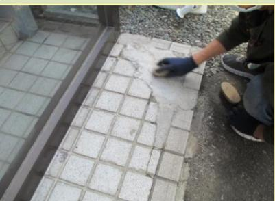
マット接地面に凹凸や水分、油分があると密着しない為、平らになるようにゴミなどを取り除き、乾燥させます。地面が割れてしまっている場合、モルタルなどで平らに成形します。
