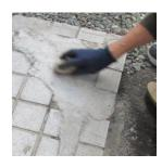
接着する箇所にひび割れや穴がある場合は、補修して平らにしてください。 タイルの目地、縞鋼板の凸凹程度は問題ありません。 ゴミ、油分、水分があると接着しないので、きれいに清掃し乾燥させます。
